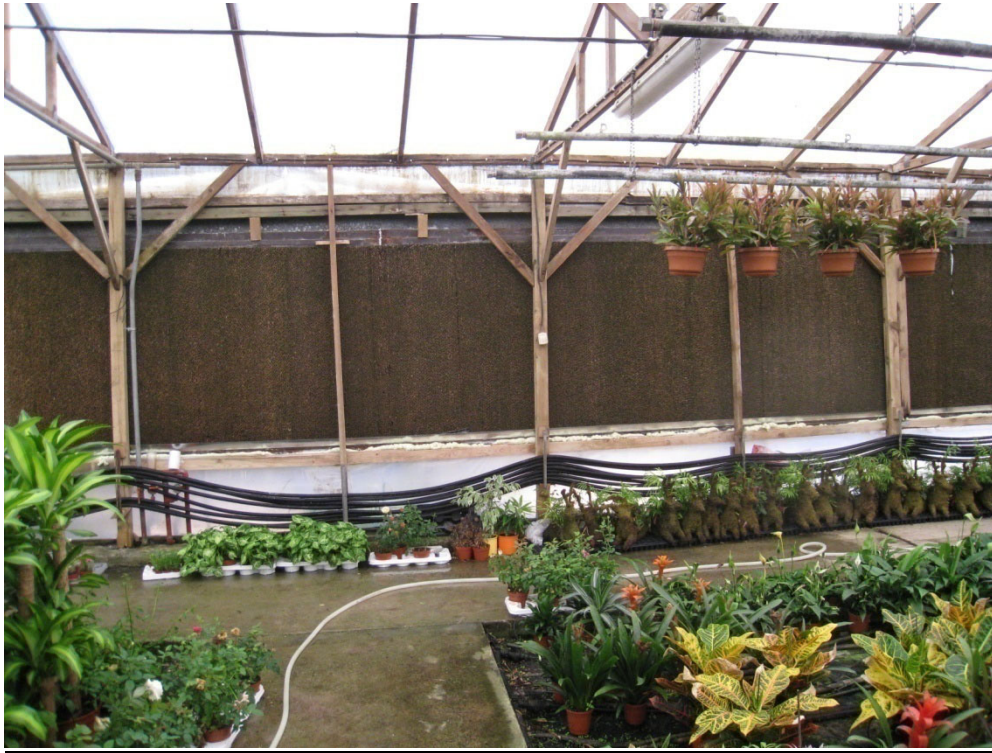
Φωτό 9. Σύστημα ψύξης του χώρου του θερμοκηπίου που καταναλώνει ηλεκτρική ενέργεια. Διακρίνονται στη νότια πλευρά του οι κυψελίδες νερού που λειτουργούν σαν εναλλάκτης θερμότητας. Ο εισερχόμενος αέρας διέρχεται μέσα από αυτές στο χώρο του θερμοκηπίου και ψύχεται.
